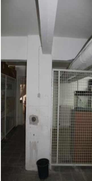
Şekil 3: Beton örneğinin alındığı bir kolon.
