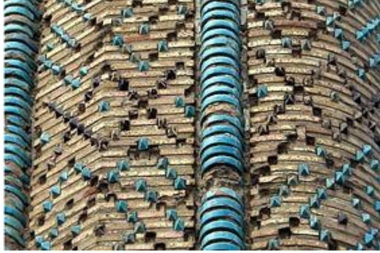
Görsel 3.1. Konya İnce Minareli Medrese minaresi, sırlı tuğla ve tuğla süsleme, 1258. Kaynak: https://twitter.com/tarihiKonya/status/1108250851406237696/photo/1
