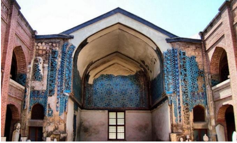
Görsel 3.7. Konya Sırçalı Medresesi https://okuryazarim.com/konya-sircali-medrese/sirçalı medrese
