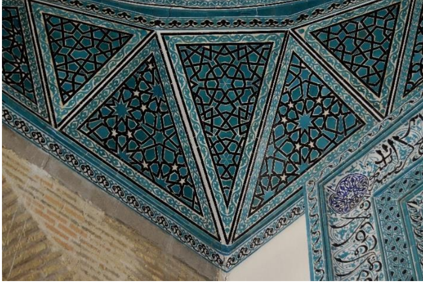
Görsel 2.32. Konya Alâeddin Camii, Kubbeye geçişi sağlayan Trük üçgeni detayı Kaynak: https://www.yenisafak.com/ramazan/sutunlar-ormani-konya-aleddin-camii-2478311
