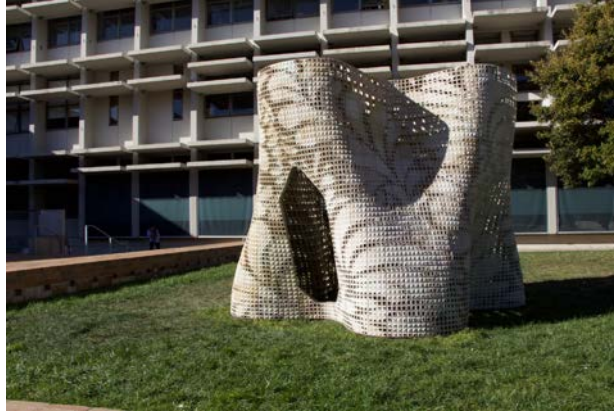
Görsel 1.5. Toz bazlı 3D yazıcı ile üretilmiş çiçek pavyonu, 2015 2
