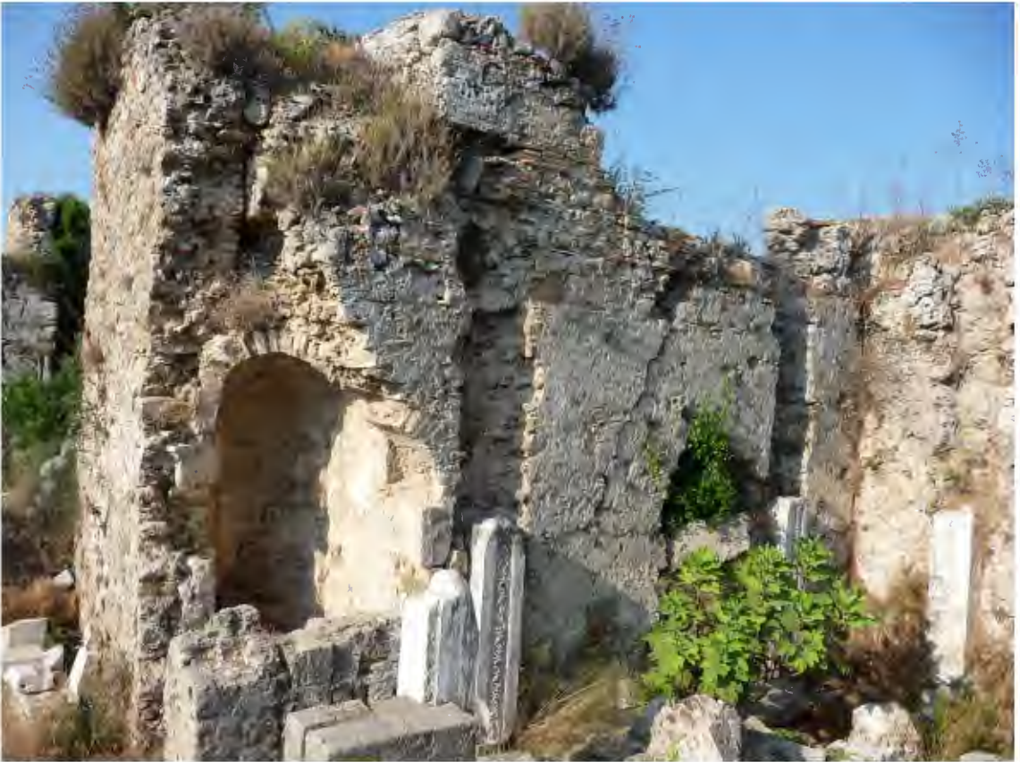
Resim 52. Piskoposluk Sarayı Küçük Kilise Güney Duvar ve Niş
