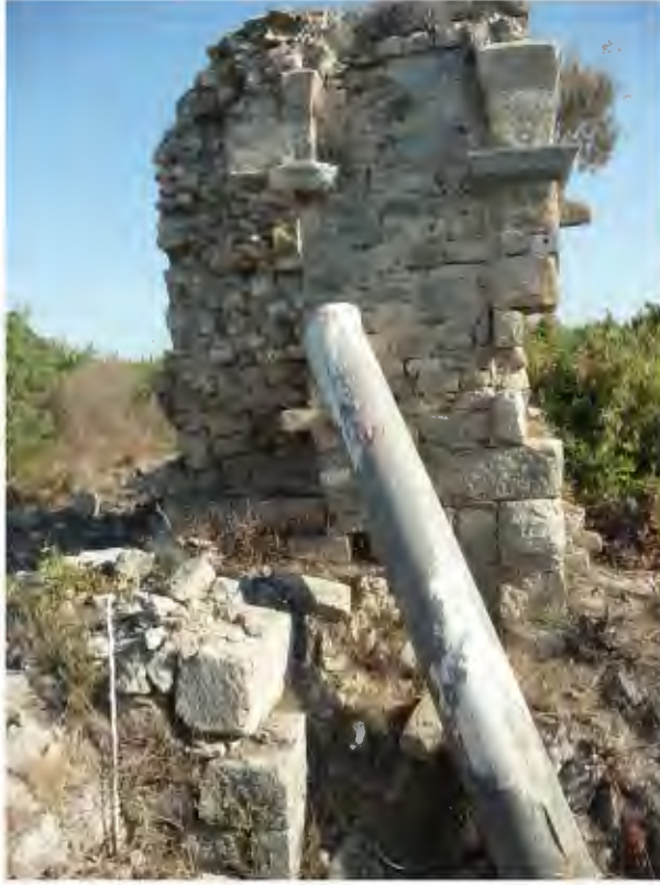
Resim 190. ee Kilisesi Kuzey Duvar
