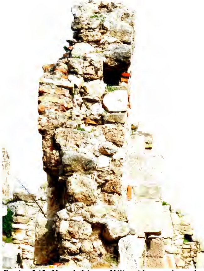
Resim 342. Kuyuk Liman Kilisesi kuzey duvar hatıl yuvası
