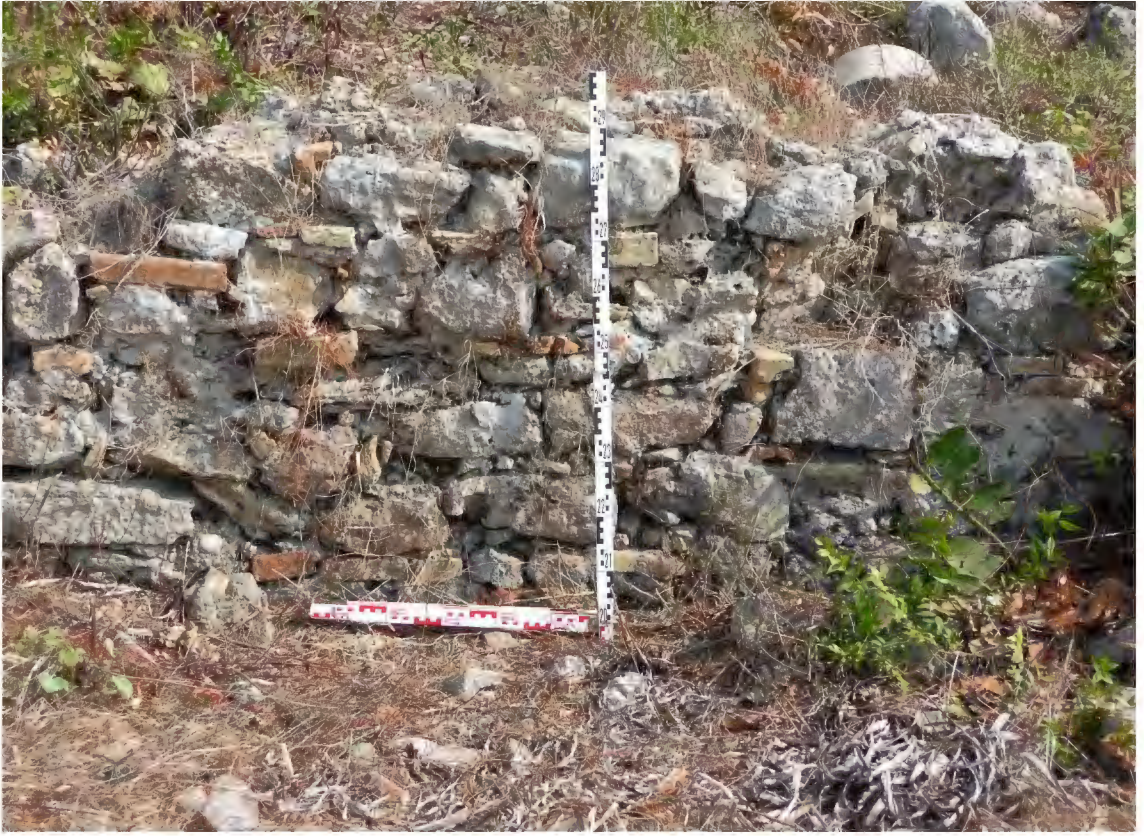
Resim 16. Piskoposluk Sarayı Kilisesi Kuzey Dış Duvar
