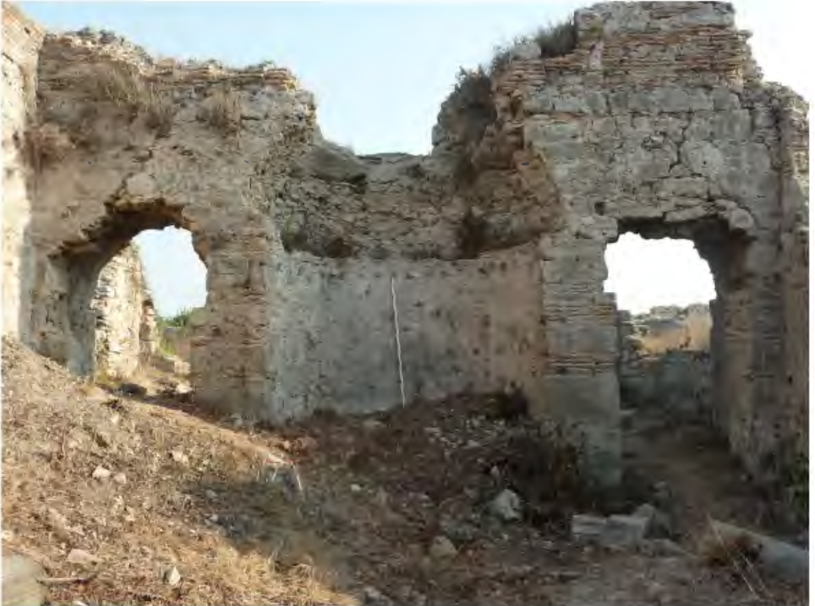
Resim 29. Vaftizhane Kuzey Duvar
