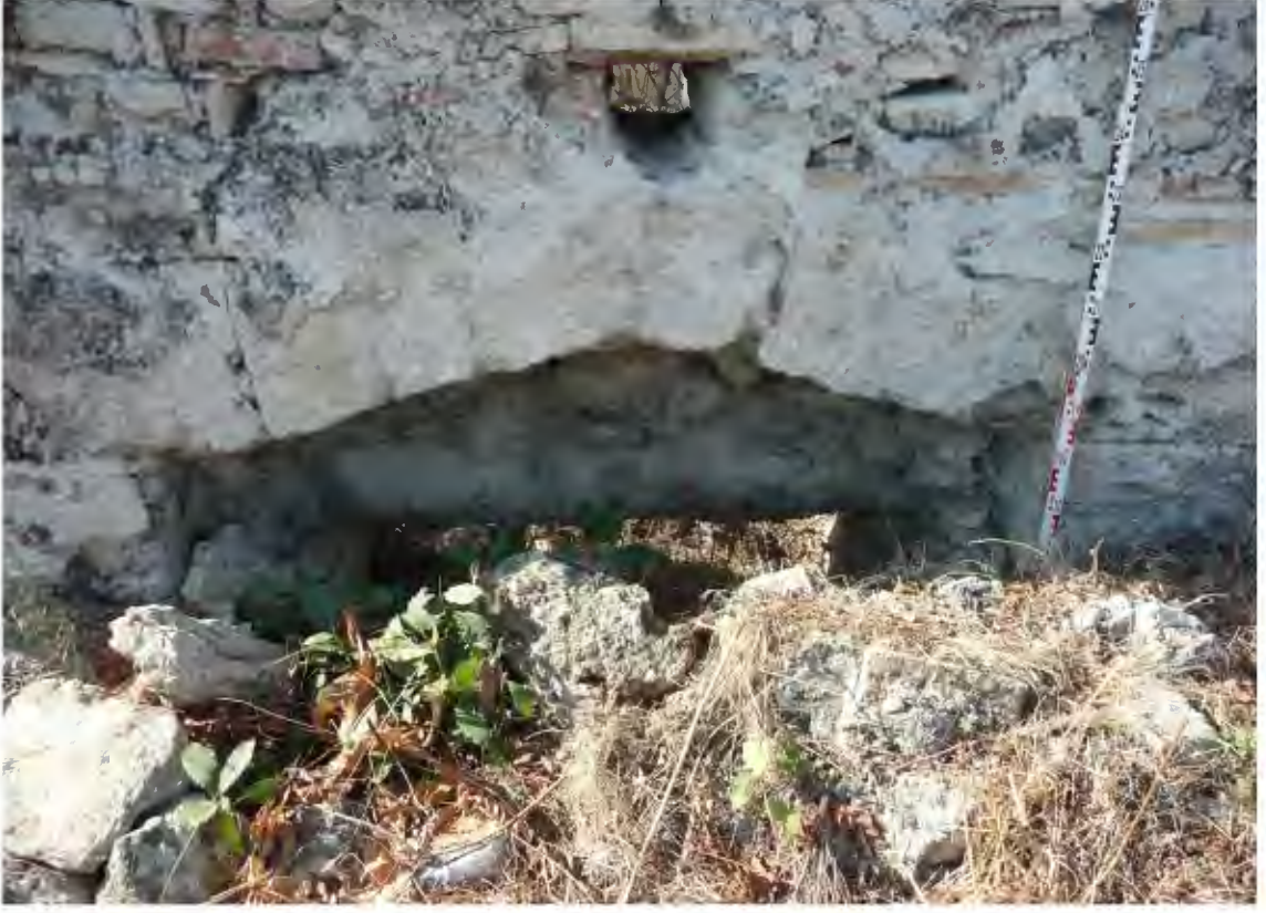
Resim 75. Piskoposluk Sarayı 5b Koridoru Kuzey Kapı
