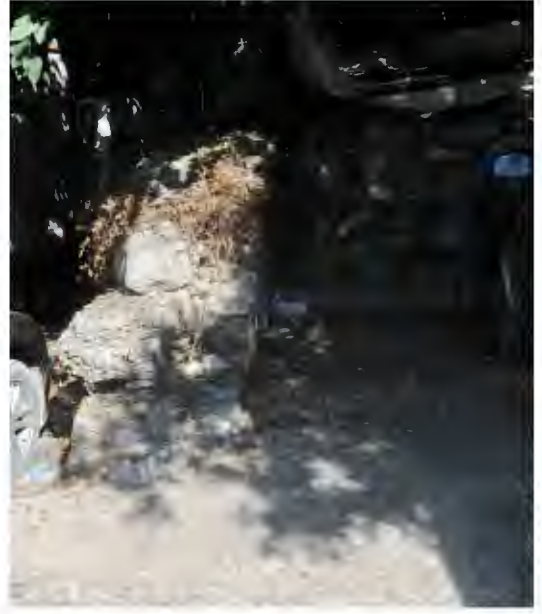
Resim 170. bb Kilisesi Güney Transept Kolu Köşesi
