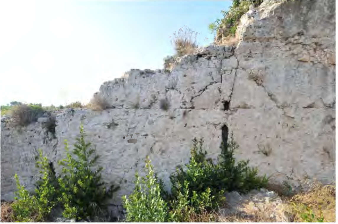
Resim 90. Piskoposluk Sarayı 6b Yapısı Kuzey Duvar
