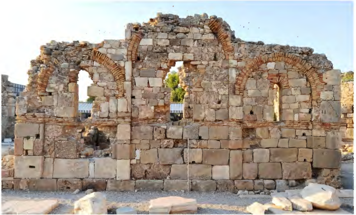
Resim 197. Küçük Liman Kilisesi, Güney Cephe
