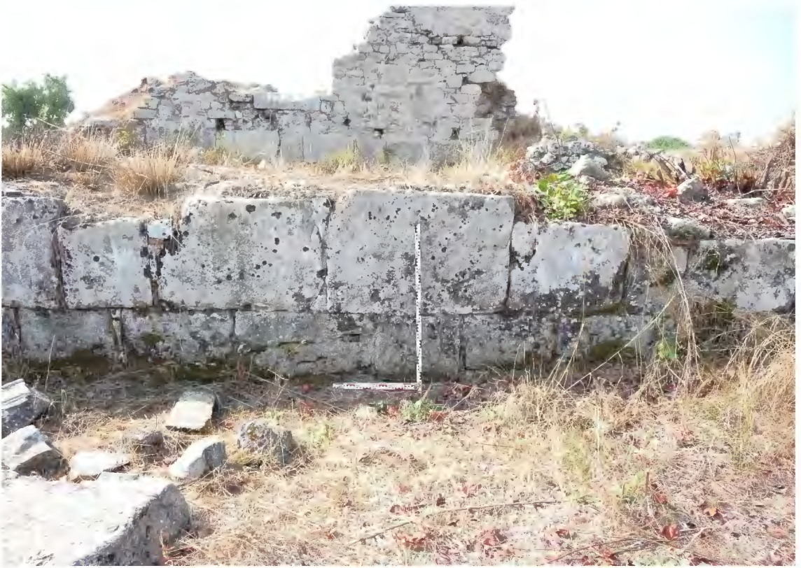
Resim 223. Piskoposluk Sarayı kilisesi kuzey iç duvar
