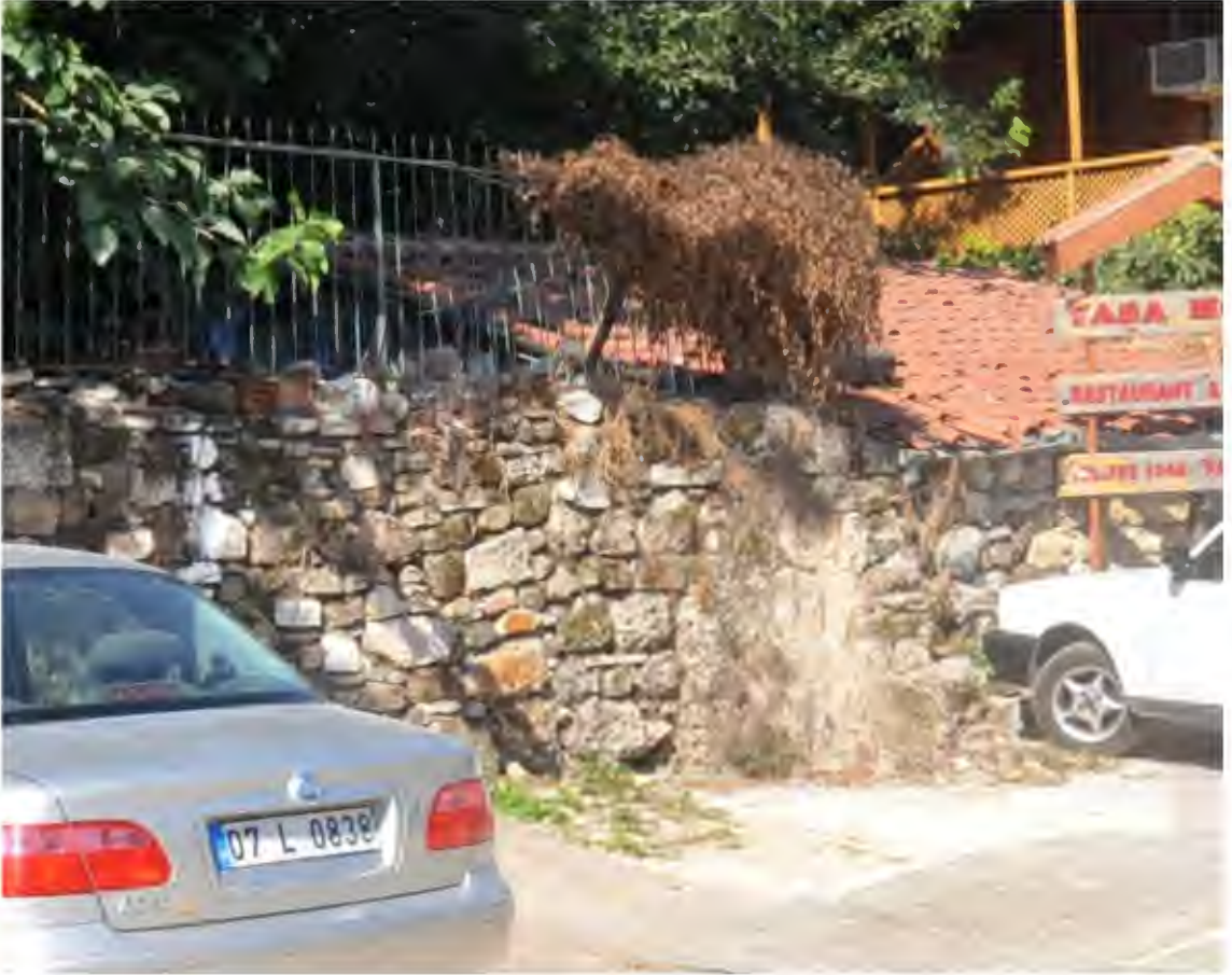
Resim 171. bb Kilisesi Güneybatı Köşe
