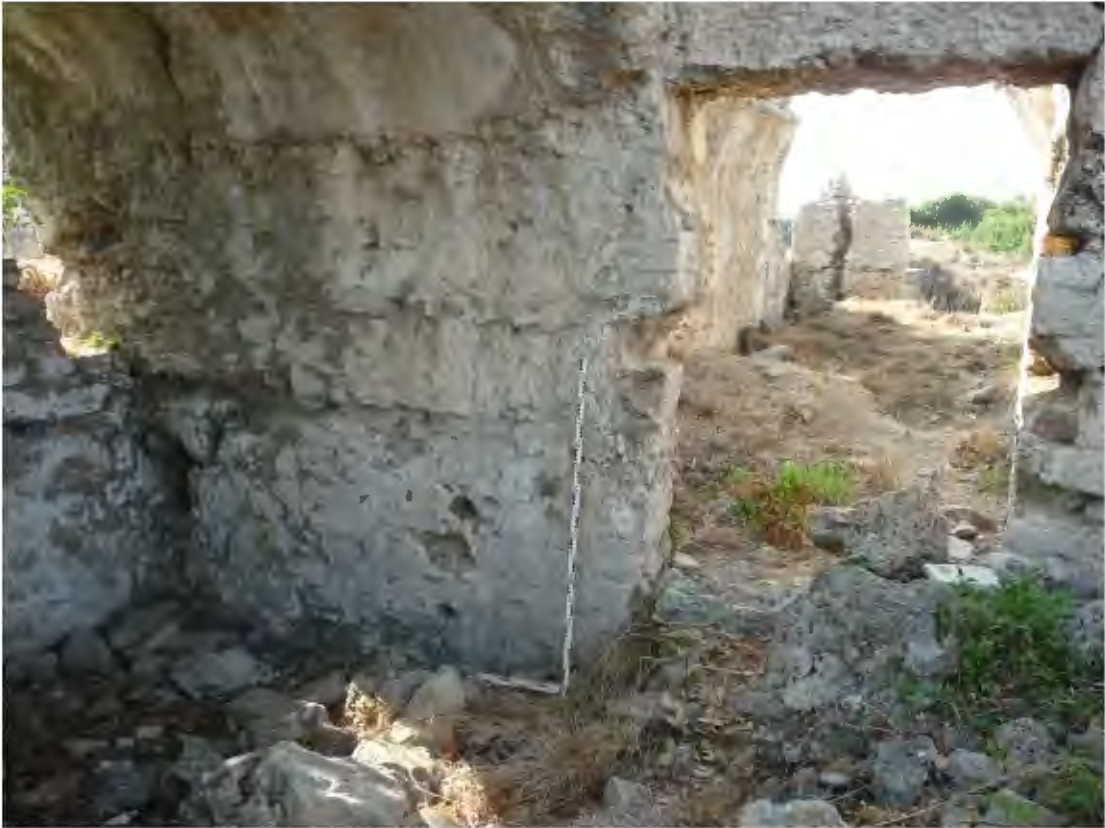
Resim 70. Piskoposluk Sarayı 5a Mekanı Güney Kapısı
