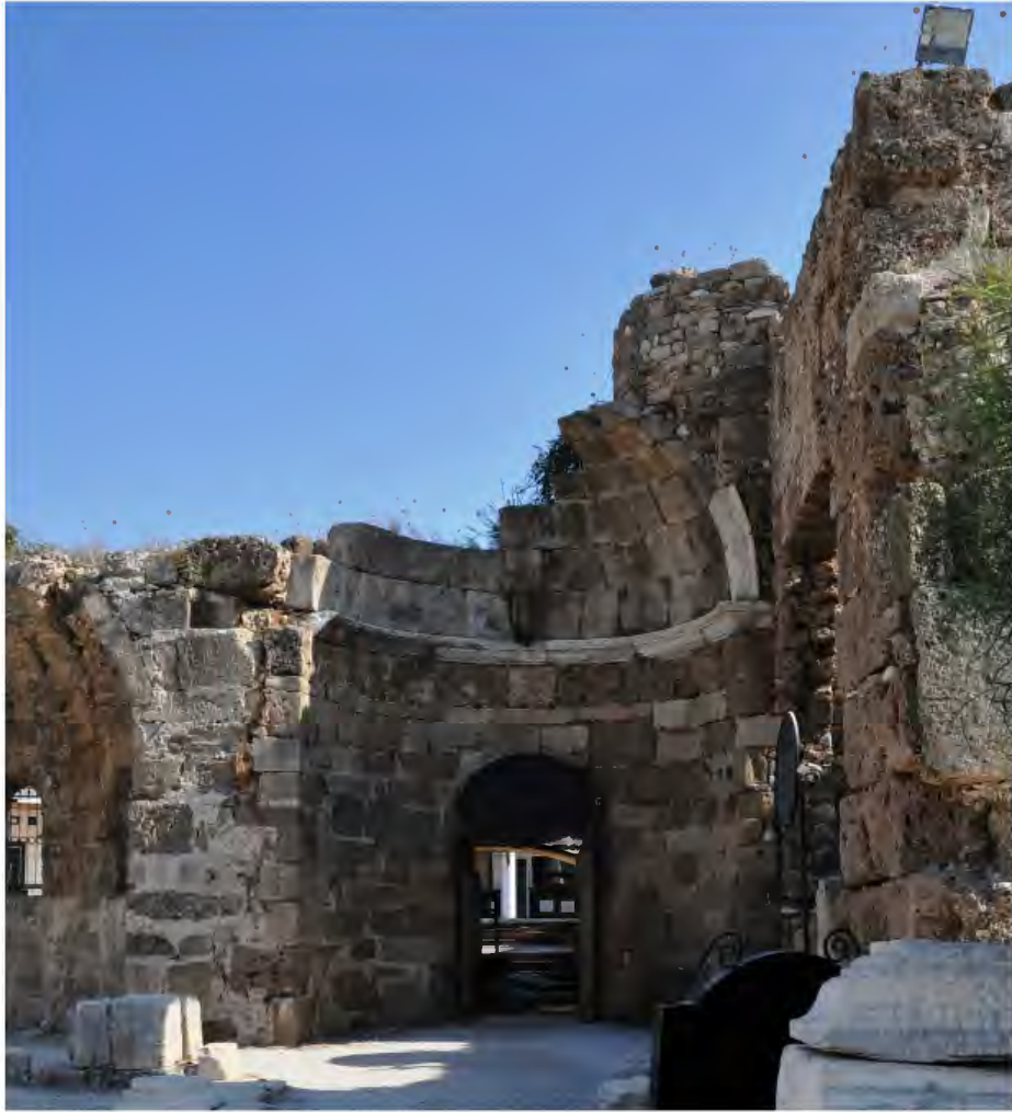
Resim 131. AA Bazilikası Atrium Kuzey Duvar Doğu Eksedra
