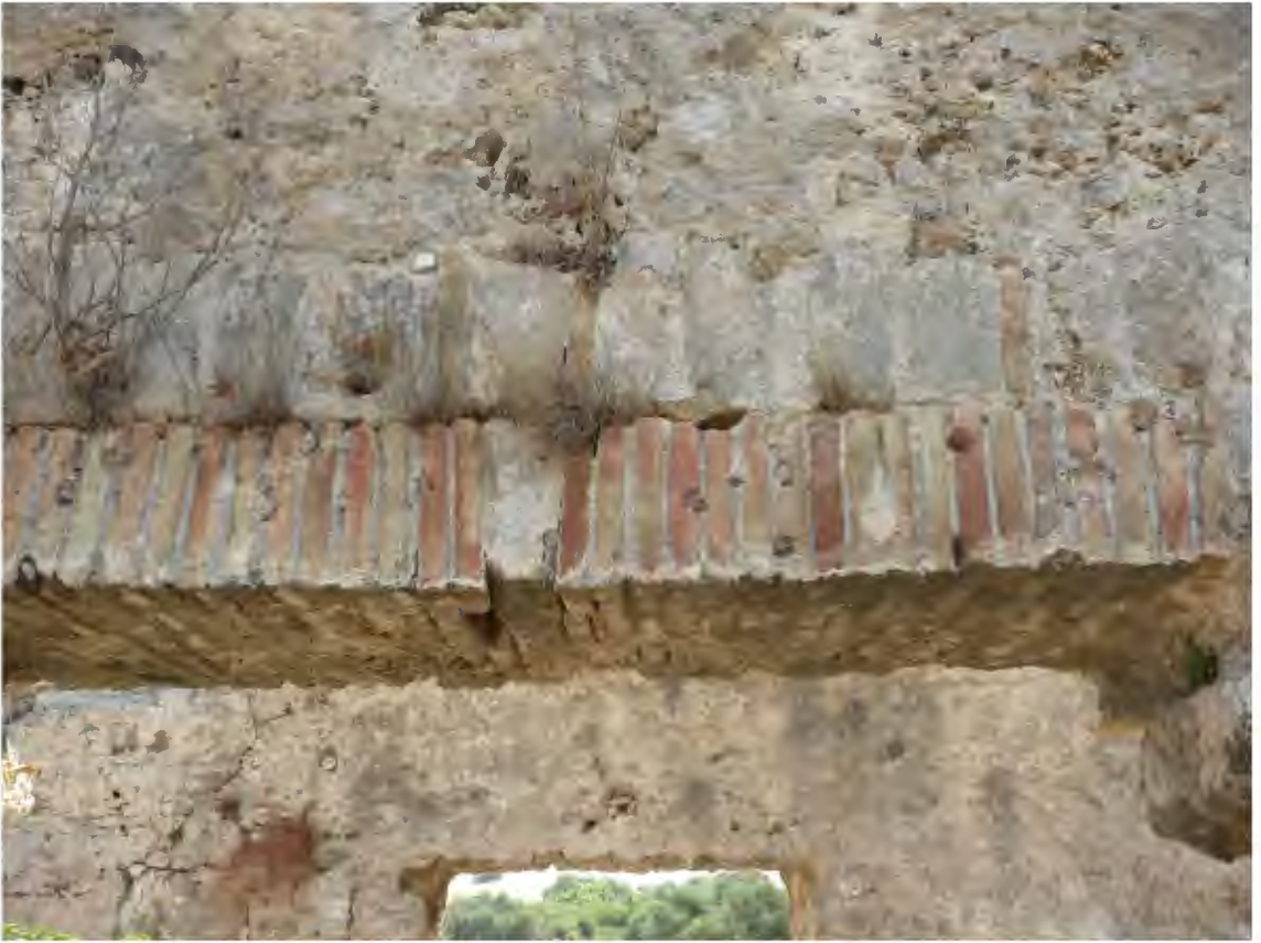
Resim 91. Piskoposluk Sarayı 6b Yapısı Batı Kapısı Lentosu
