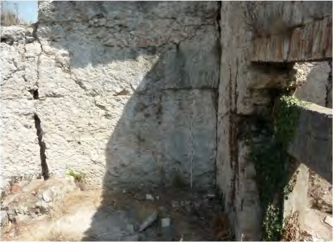
Resim 56. Piskoposluk Sarayı 6b Yapısı Kuzey Duvar
