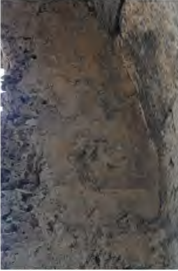
Resim 123. AA Bazilikası Martyrion Güney Mekan Batı Duvarı Detay
