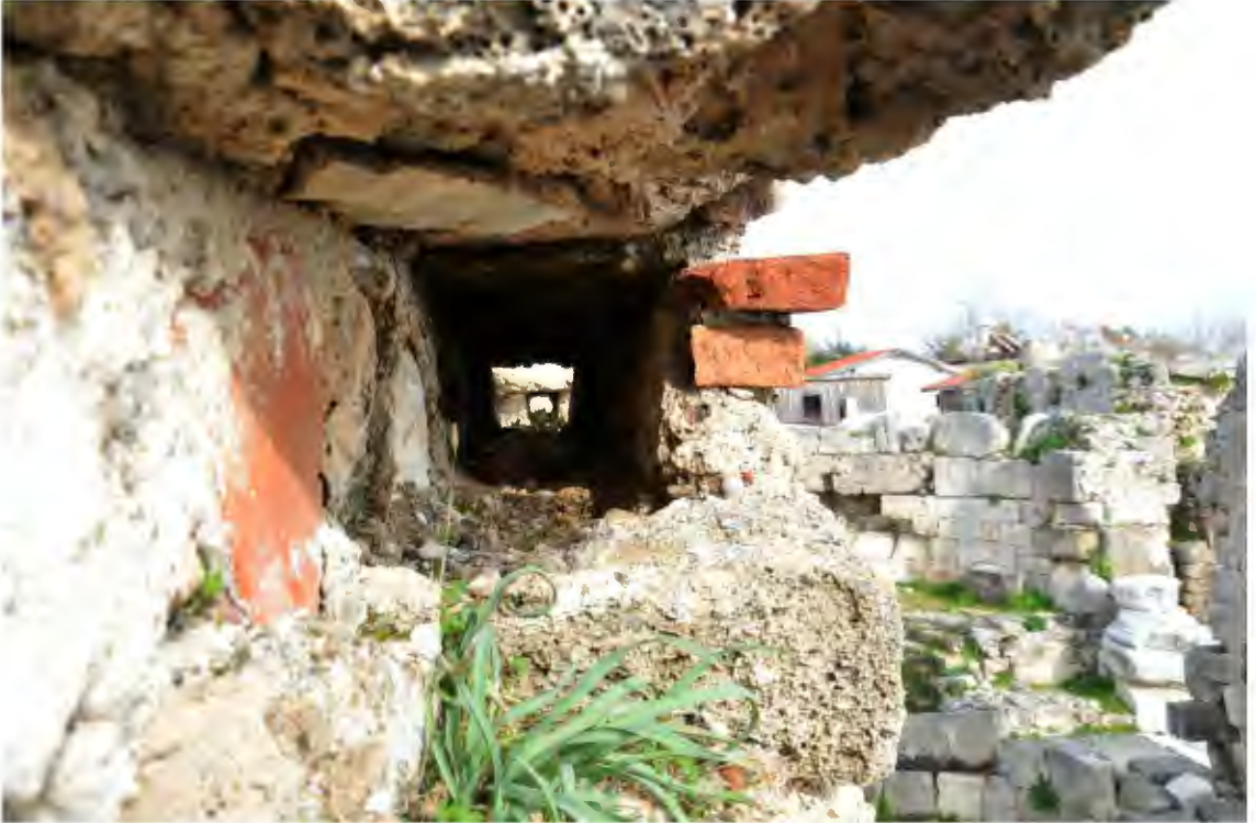
Resim 343. Kuyuk Liman Kilisesi kuzey duvar hatıl yuvası detay
