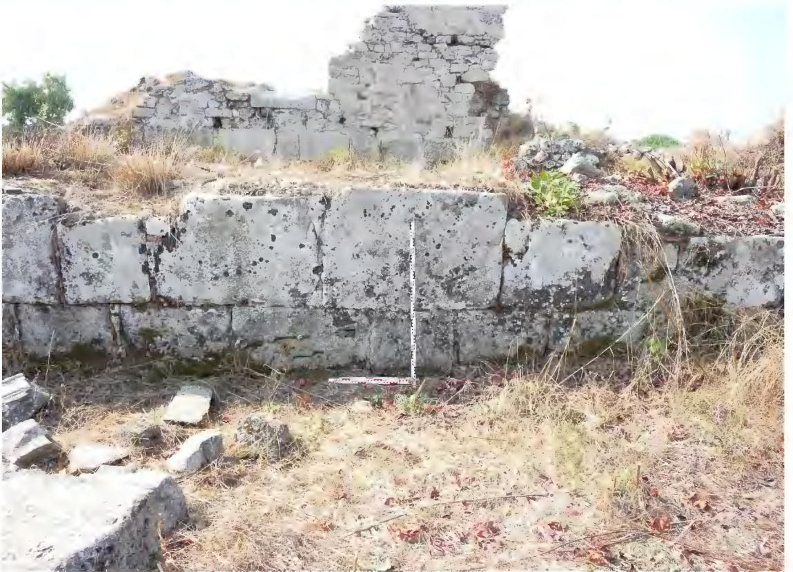
Resim 17. Piskoposluk Sarayı kilisesi Kuzey İç Duvar
