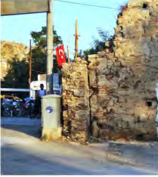
Resim 169. bb Kilisesi Kuzeydoğu Köşe
