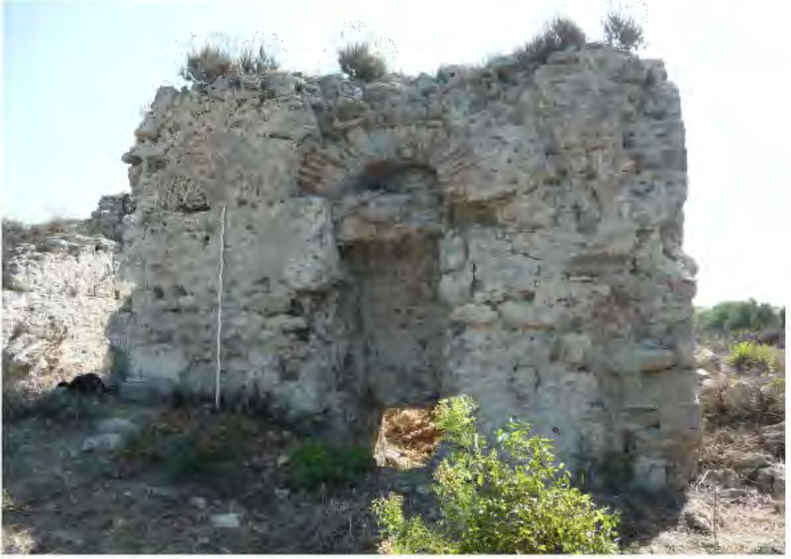
Resim 92. Piskoposluk Sarayı 6b Yapısı Güney Mekan Batı Cephesi
