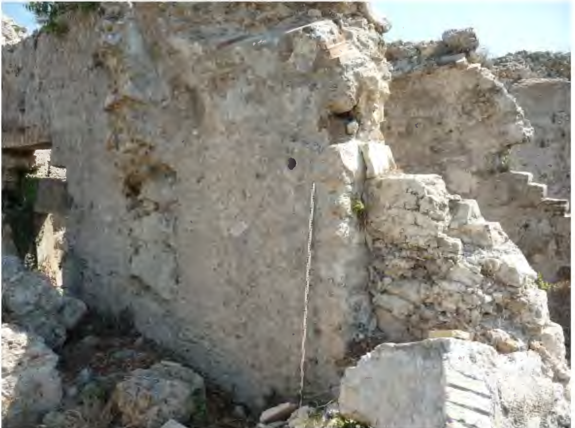
Resim 60. Piskoposluk Sarayı 6b Yapısı Güney Mekan Doğu Kapısı
