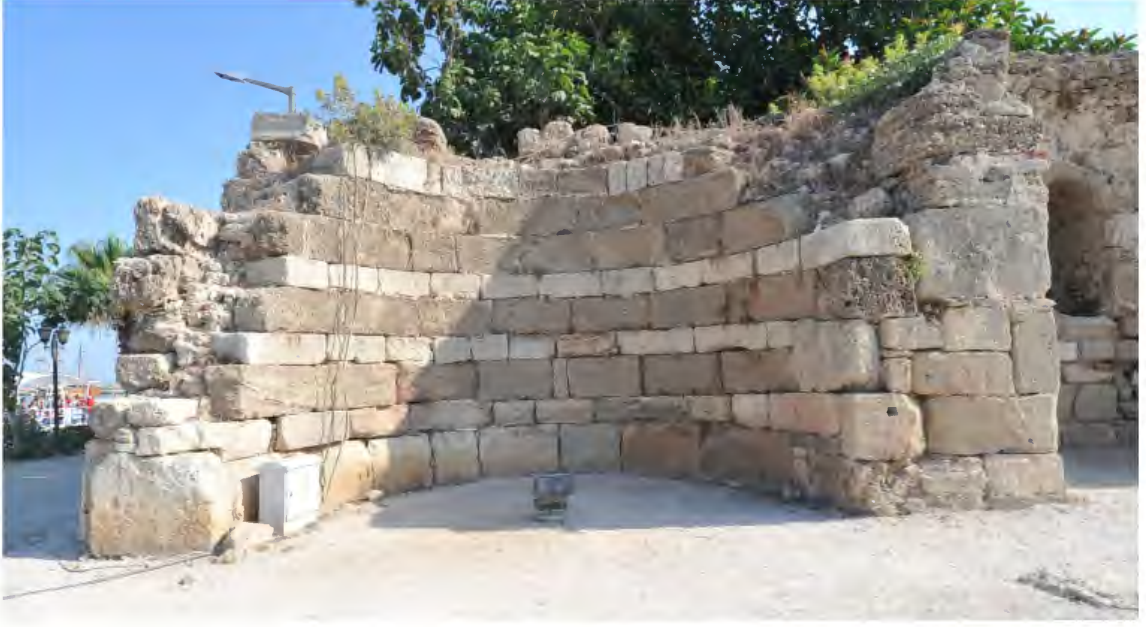
Resim 130. AA Bazilikası Atrium Kuzey Duvar Batı Eksedra
