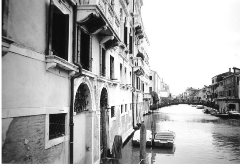
Şekil 8. Ghetto Nuovo Ghetto Nuovo'nun kuzey yönünde kente bağlantısı San Girolamo Kanalı üzerinden sağlanmaktadır. Köprü'nün kente bağlandığı noktada kontrol kulesi halen mevcuttur. (Sevim Ateş tarafından 2005 yılında çekilmiştir.)
