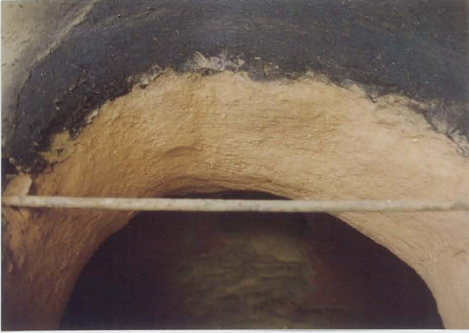
Resim 23: Kubbenin Yapımı Atkuların ve Çubukların Yerleştirilmesi
