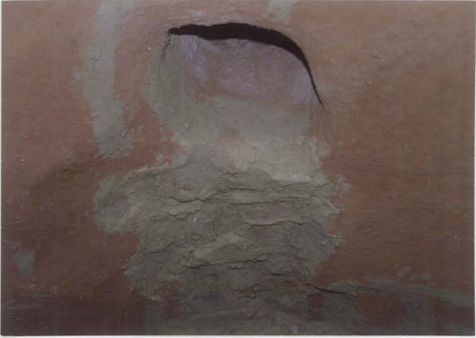
Resim 24: Kubbenin Yapımı Tuğlaların Örülmesi
