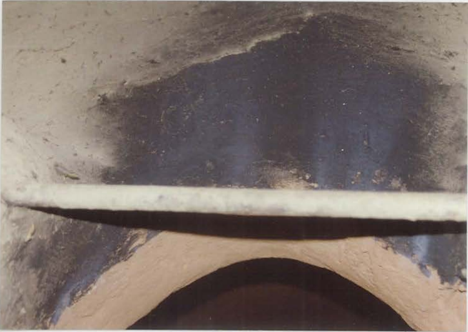
Resim 21: Demir Çubukların Yerleştirilmesi (Gergi Çubukları).
