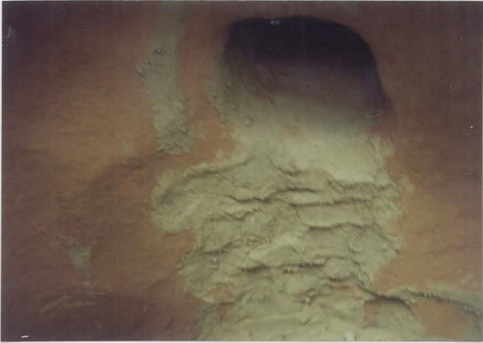
Resim 27: Fırın Sıvasının Yapılması (Fırının Sıvanması)
