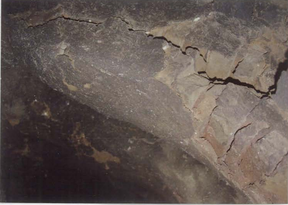
Resim 19: Ateşlik Bölümünün Yapımı
