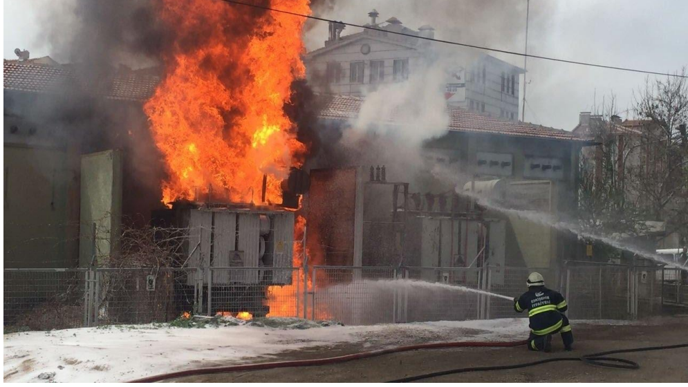
Görsel 5.1. Eskişehir Höyük İM' de yanan 10MVA güç trafosu (5 Nisan 2017)
