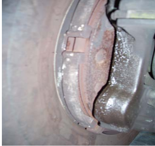
Şekil 6.9 Fren bölgesi üzerinde tespit edilen korozyon
