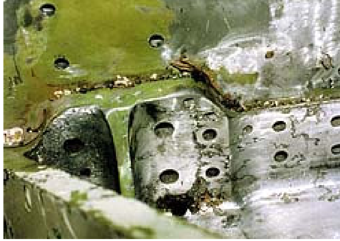
Şekil 2.4 Bir alüminyum alaşımlı (7075-T73) malzeme üzerinde çukurcuk korozyonu [5]
