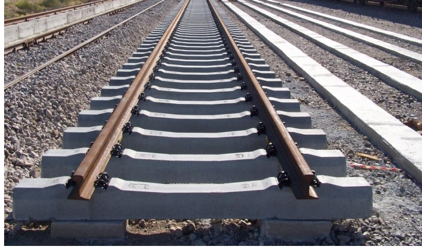
Şekil 3.8. B 70 Tipi Beton Traversler [28]
