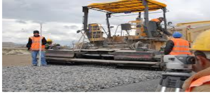
Őekil 3.9. Balast inŐaatı [29]
