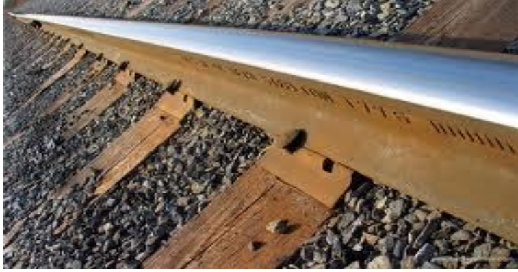
Şekil 3.17. Eksik bağlantı vidaları [31]
