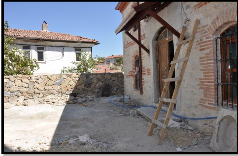
Şekil 5. Cami Dokusunun Temizlenmesi
