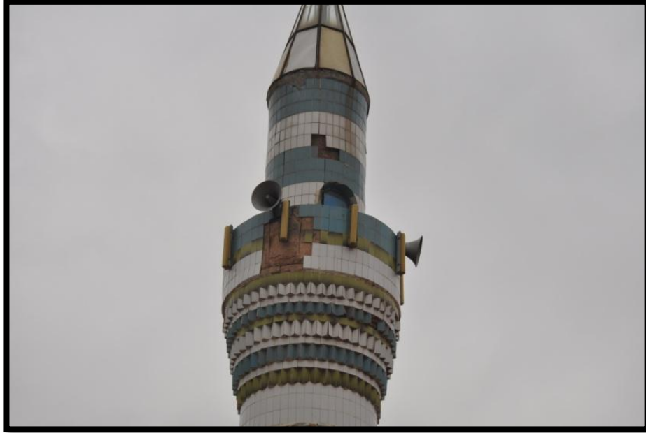
Şekil 4. Minare İlk Hali,
