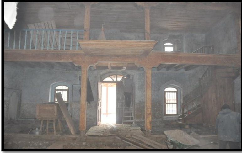
Şekil 8. Raspa ve Zemin Sökümü Sonrası
