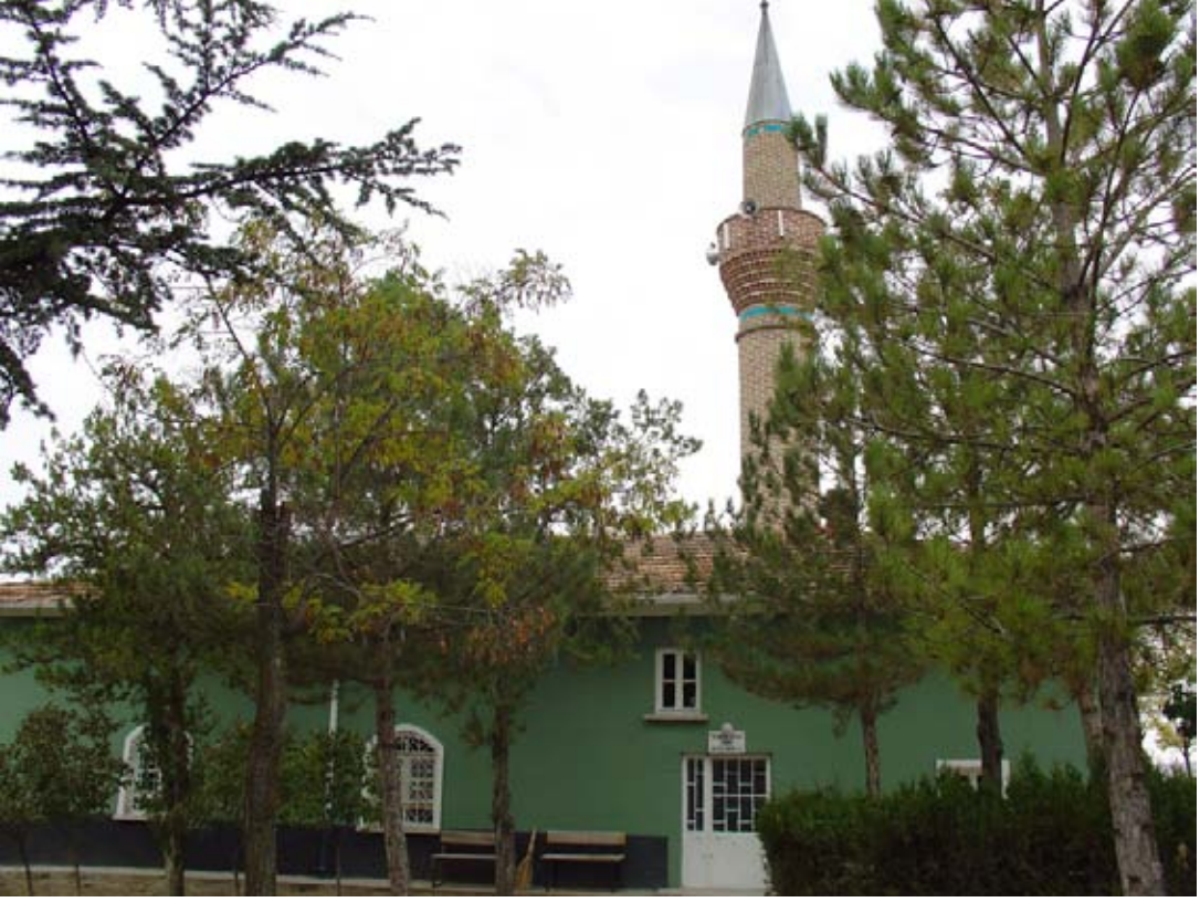
Resim 16: Yeniköy Camii Doğu Cephe
