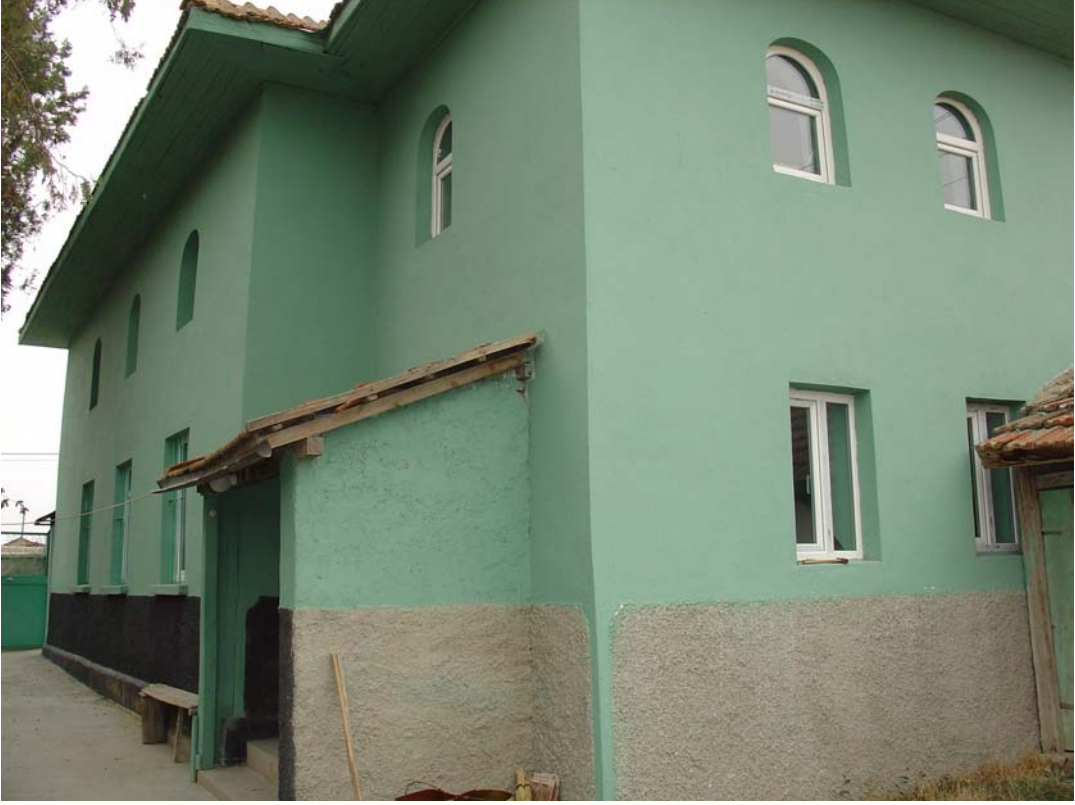
Resim 41: İsmet Paşa Köyü Küçük Mahalle Camii Doğu Cephe
