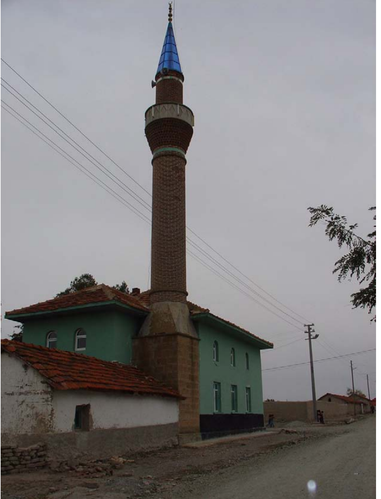
Resim 43: İsmet Paşa Köyü Küçük Mahalle Camii Kuzey ve Batı Cepheler
