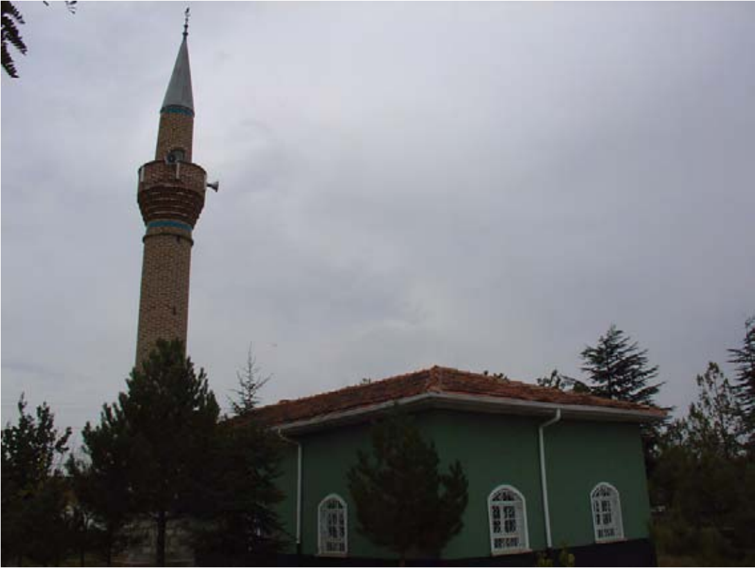
Resim 17: Yeniköy Camii Batı ve Güney Cepheler
