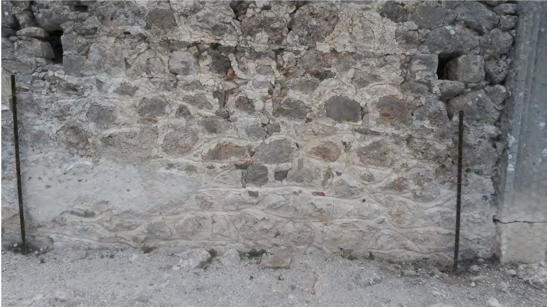
b) Tlos Kent Bazilikası, dalgalı çizgili derz harcı.
