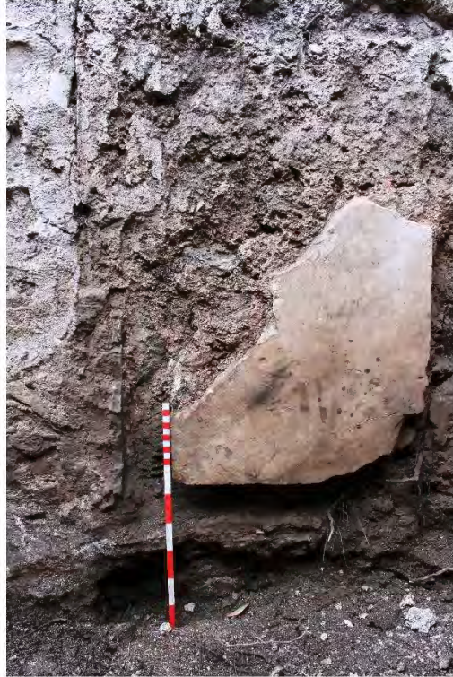
b) Liman Bazilikası kuzey ek mekanın doğusunda yer alan trikonchos niş, dış cephe kaplaması.
