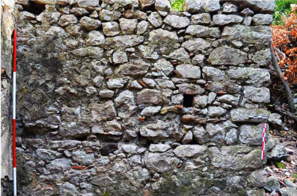
b) Yamaç Yerleşimi Aşağı Kilise doğu duvar iç cephe detay.
