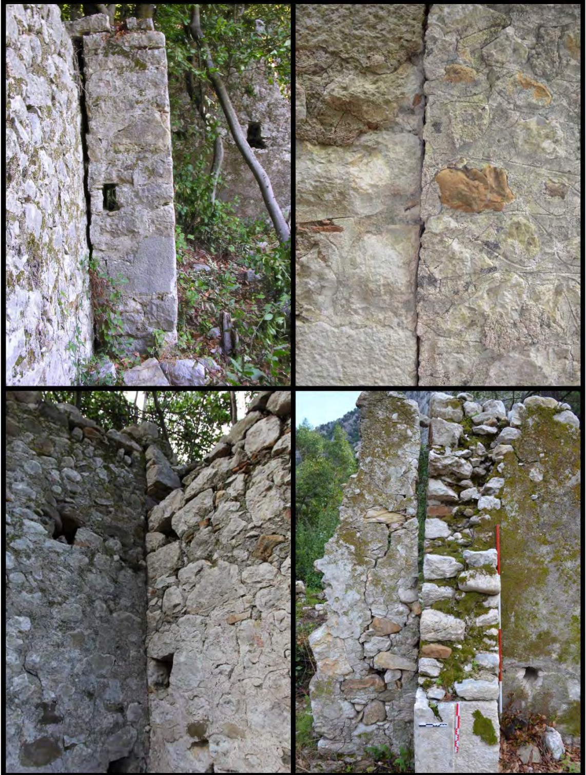
a) Piskoposluk Kilisesi dilatasyon derzi uygulaması.
