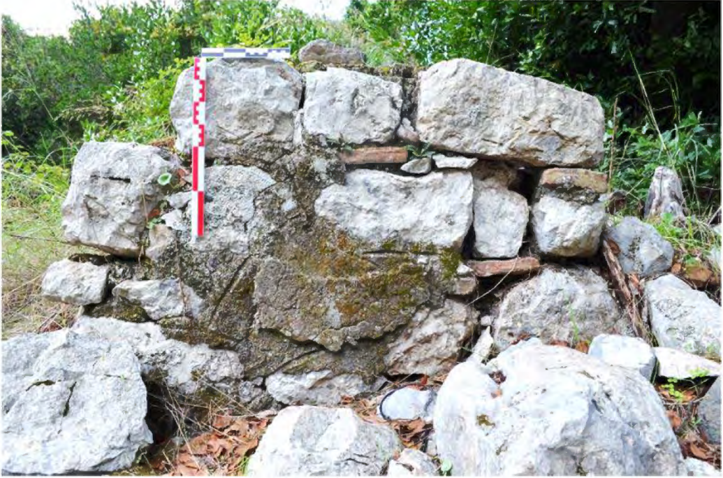
a) Liman Bazilikası kuzey ek mekan güney duvar, dalgalı çizgili derz harcı ve sıva tabakası.
