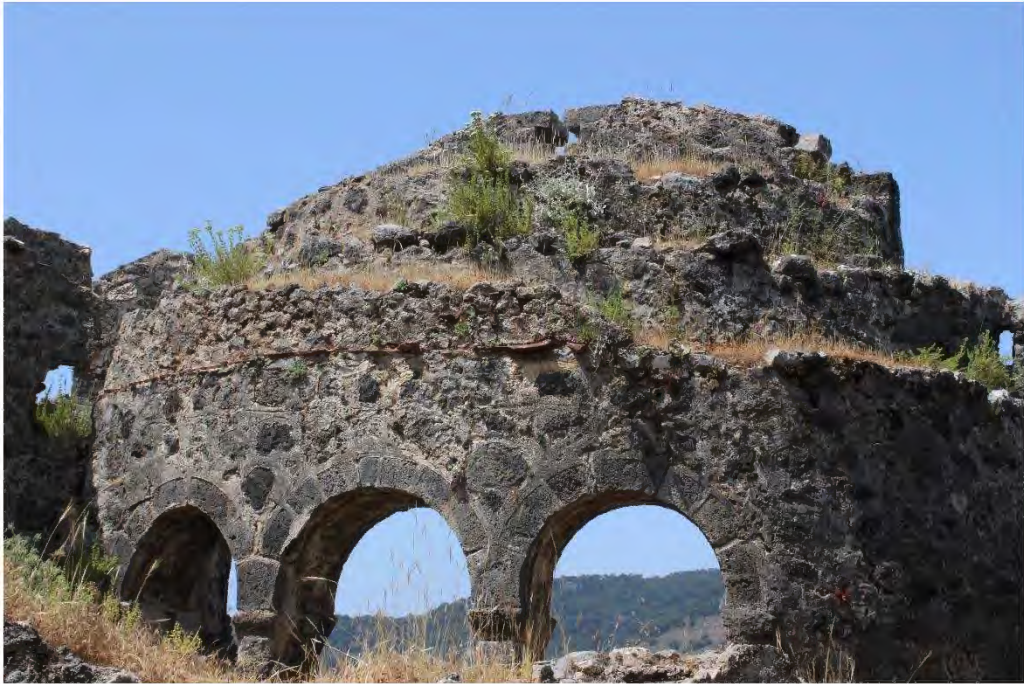
b) Gemiler Ada II nolu Kilise apsis duvarı, dış cephe, dalgalı çizgili derz harcı.
