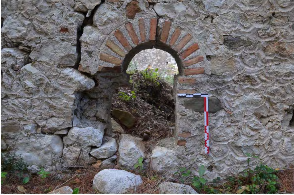
a) Piskoposluk Kilisesi rölik şapeli güney pencere.
