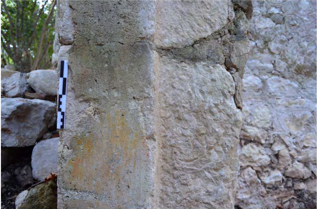
b) Piskoposluk Kilisesi'ndeki in situ söve üzerinde tespit edilen sıva tabakası.
