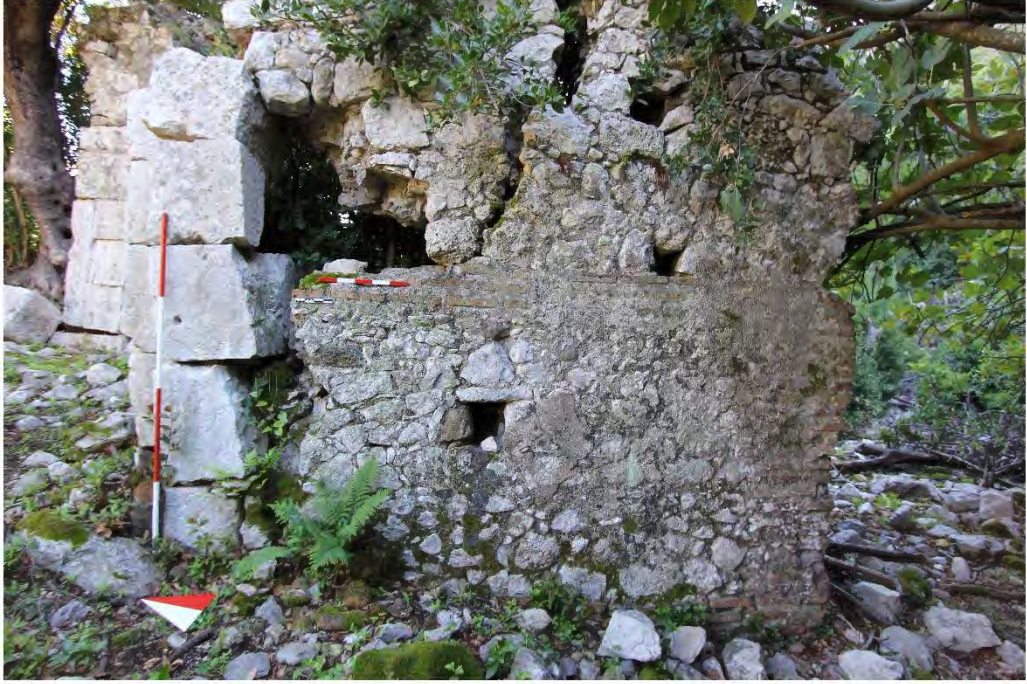
a) Liman Bazilikası güney nef dođu duvar.
