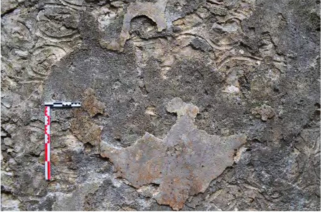
a) Yamaç Yerleşimi Aşağı Kilise iç cephe dalgalı çizgili derz harcı ve sıva tabakası.
