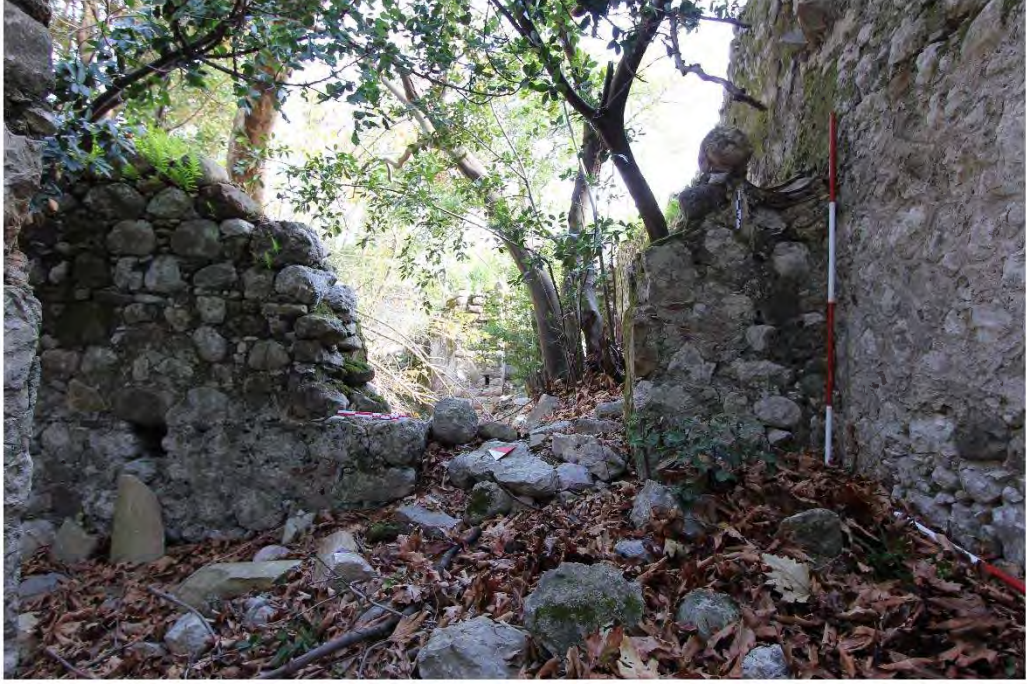
a) Vaftizhane güney nefine açılan kapı açıklığı, doğuya bakış.
