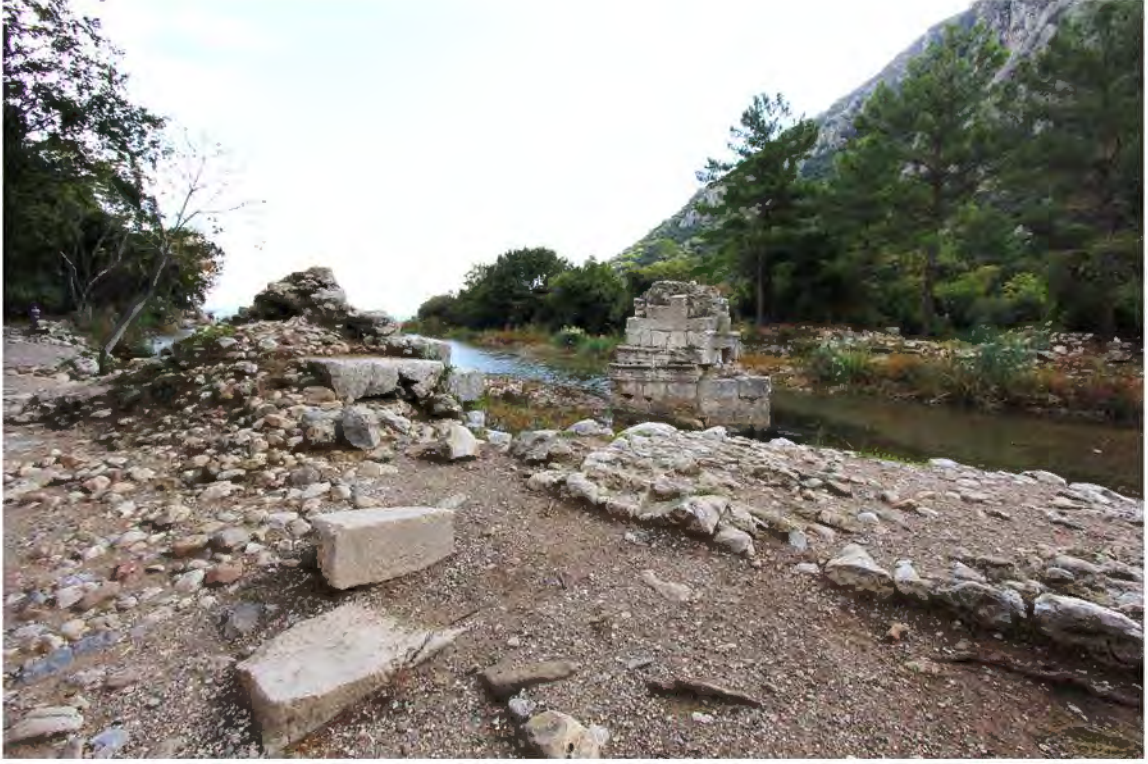
a) Kuzey köprü ayağı ve köprü basamakları, batıdan bakış.
