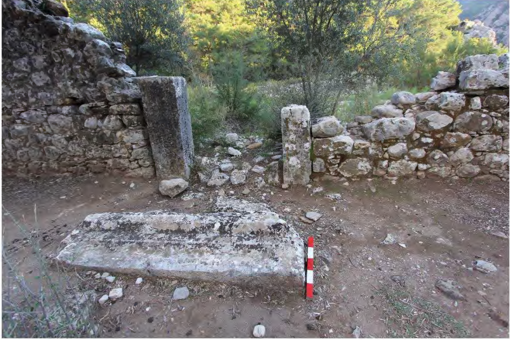
a) Nekropol Kilisesi atrium giriş açıklığı.
