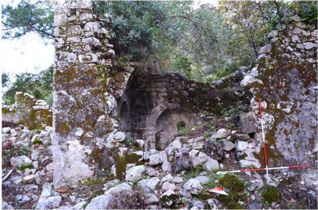
b) Piskoposluk Kilisesi rölük şapeli kapı açıklığı
