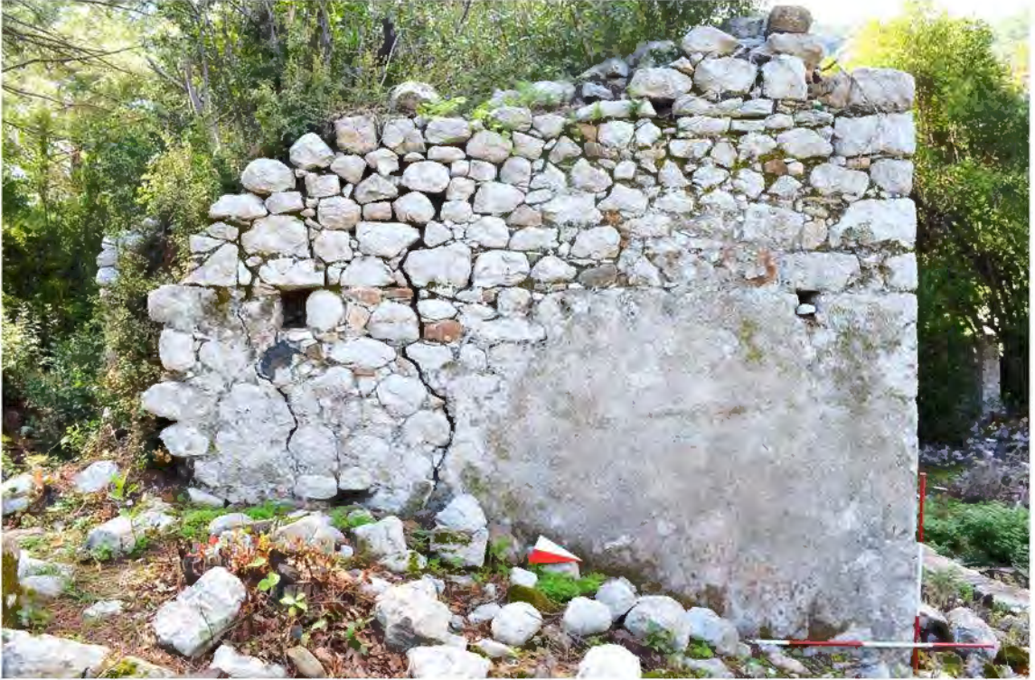
b) Piskoposluk Kilisesi güney transept kolu batı duvar örgüsü.
