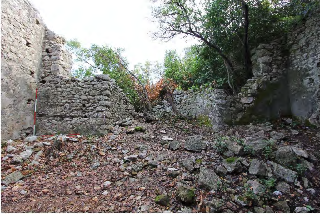
a) Yamaç Yerleşimi Aşağı Kilise apsis cephesi.
