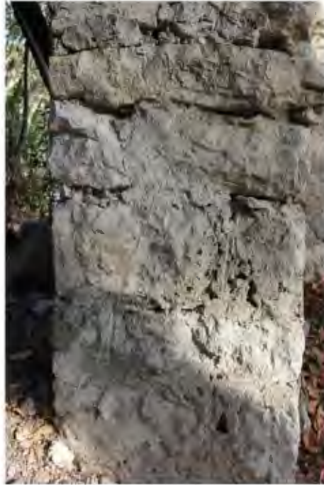
b) Piskoposluk Kilisesi güney ek mekan batı duvardaki kapı örgüsü.
