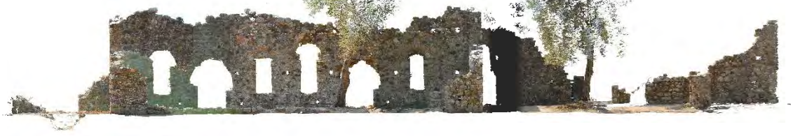
a) Nekropol Kilisesi kuzeyden genel görünüş.
