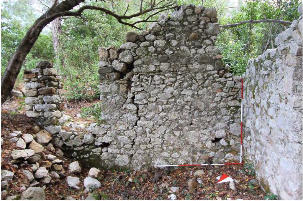
a) Piskoposluk Kilisesi güney ek mekan güney duvar.
