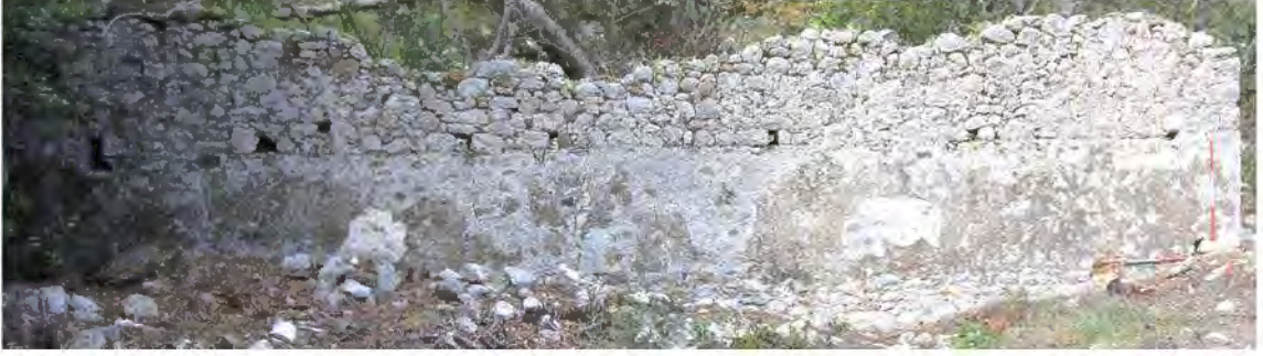
a) Piskoposluk Kilisesi kuzey nef duvarı.
