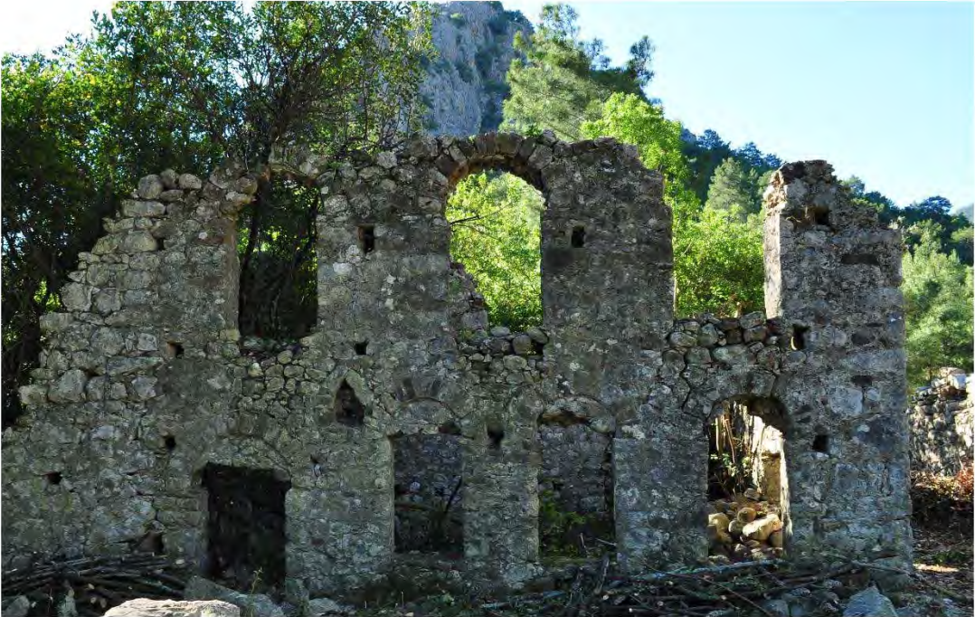
b) S6-VIII söktöründe yer alan yapı, kuzey duvar dış cephe.
