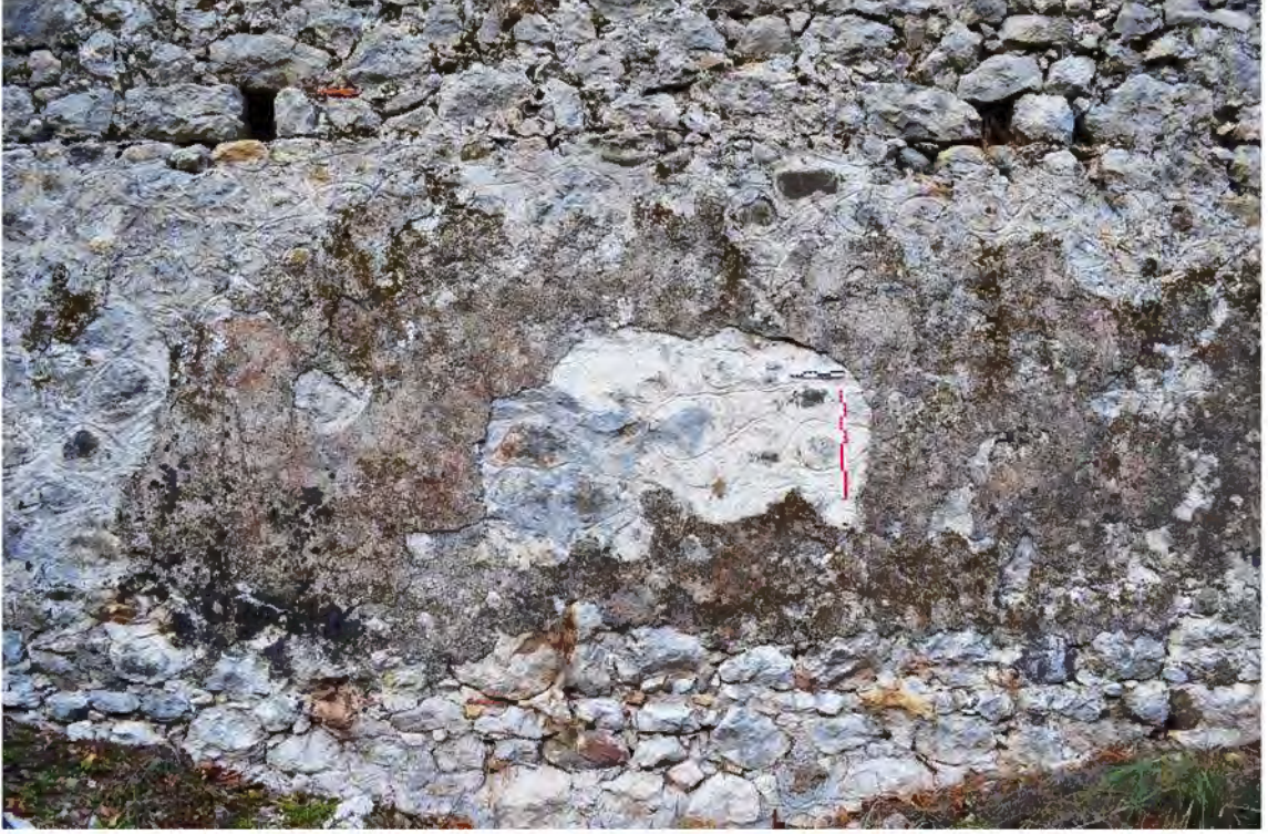
a) Piskoposluk Kilisesi kuzey nef duvar örgüsü detay.
