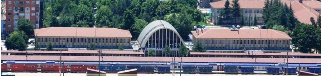
Şekil 14. Gar Binası arka cephe (Can Düz)
