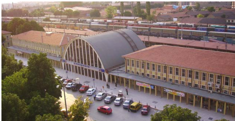
Şekil 13. Gar Binası (G. Koca, 2009)
