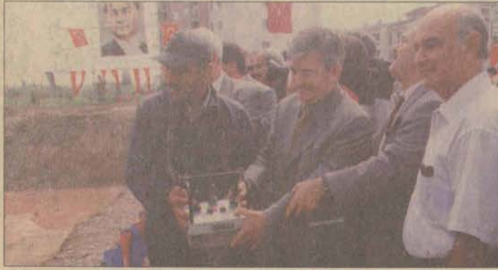
I.I.B.F. Ek Binasının yapımına Üniversite lojmanlarının arka tarafında başlandı.
