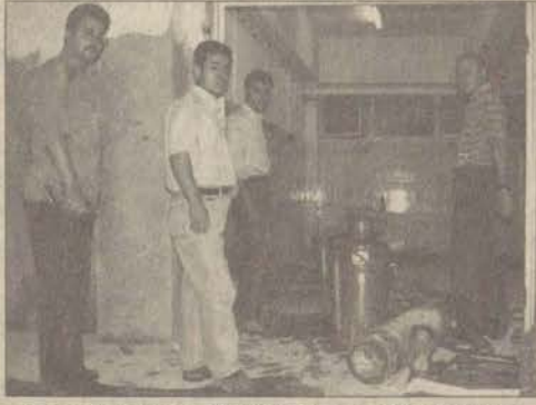
Yemekhanenin mutfak bölümünün tadilatı yapılıyor
