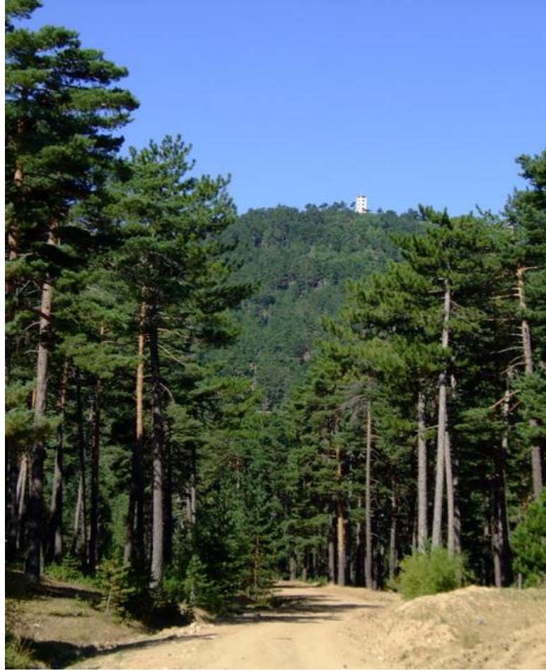
Şekil 4.2.1.1. Eskişehir, Alpu, Asaralanı, yangın gözetleme kulesi genel görünüm
