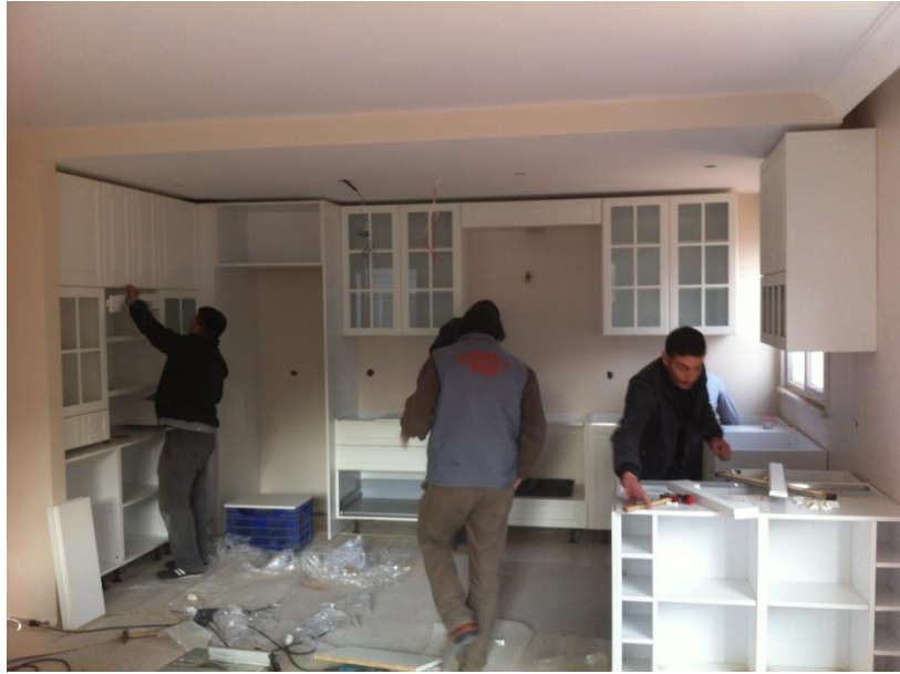
Görsel 4. Uygulama Aşamasında Mutfak Montajından bir kare
