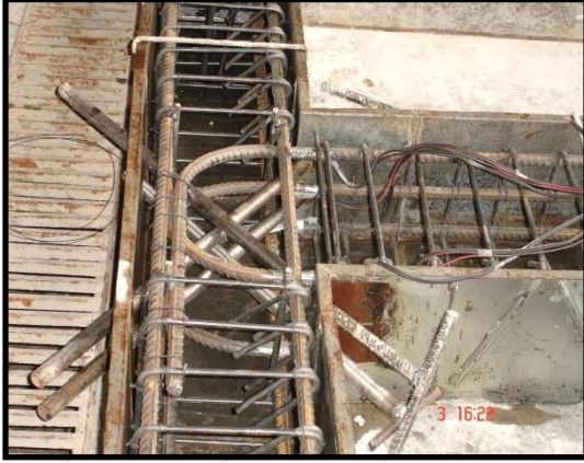
Şekil 2 a. Kalıpta bırakılan boşluklar
