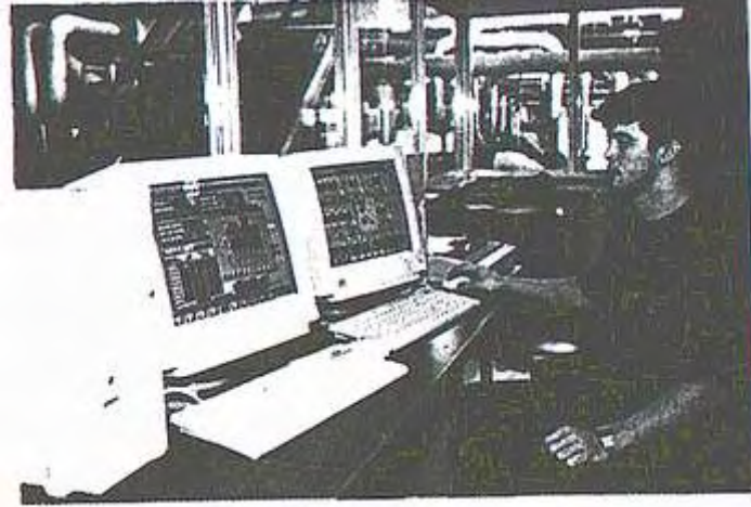
Şekil 17. Bir Merkezi Kontrol Odası
